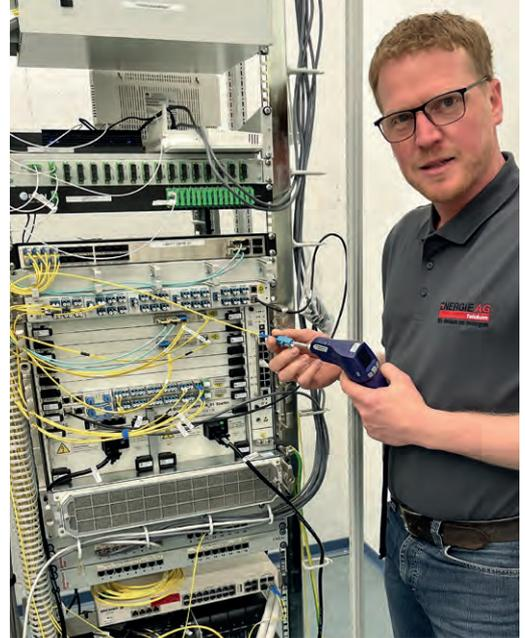
Foto oben: Saubere Faser-Enden sind bei einem DWDM-System von extremer Bedeutung. Matthias Lueger prüft die Sauberkeit hier mit dem Fasermikroskop.
