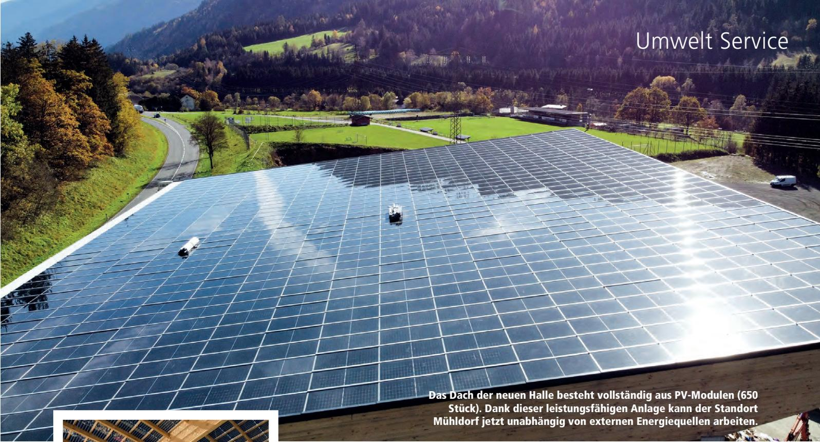
Das Dach der neuen Halle besteht vollständig aus PV-Modulen (650 Stück). Dank dieser leistungsfähigen Anlage kann der Standort Mühldorf jetzt unabhängig von externen Energiequellen arbeiten.
